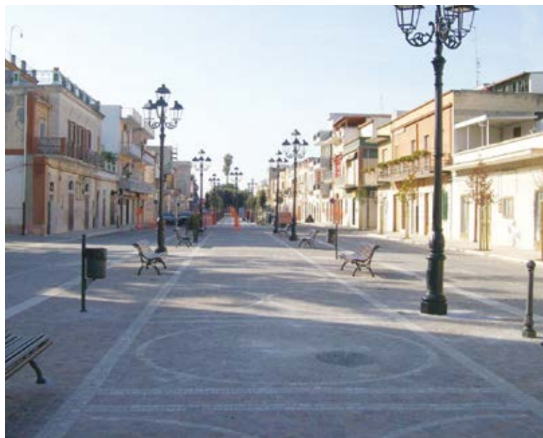
Sistemazione di Viale Vittorio Veneto con realizzazione di nuova condotta pluviale.
