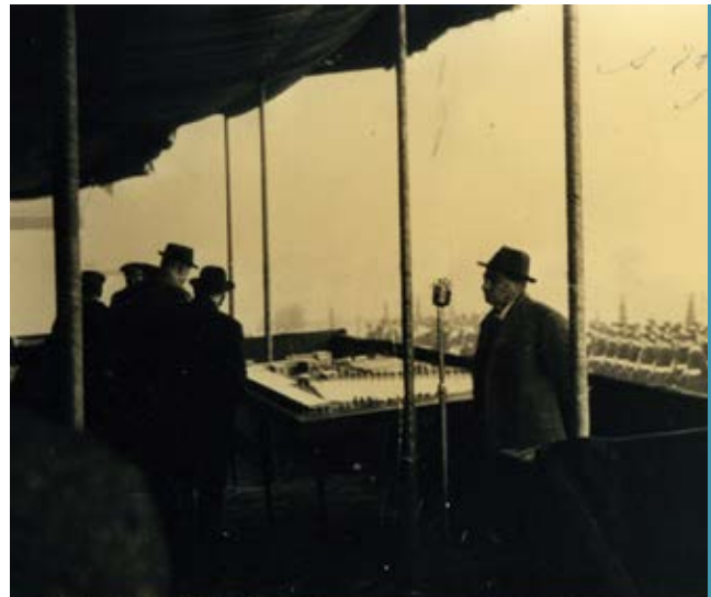
ROMA, 5 FEBBRAIO 1964. S.E. PARILLI ESAMINA IL PLASTICO DEL NUOVO CENTRO DI IDRODINAMICA. IL CAPO DELLO STATO SEGNI, PONESSE LA PRIMA PIETRA DELLA NUOVA VASCA
